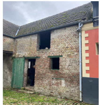
RDC // Futur accès Cour intérieure
