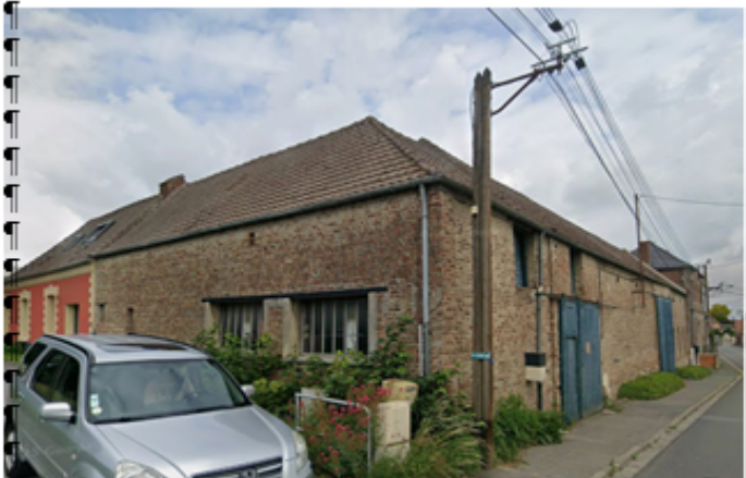
Photo du bâtiment existant
