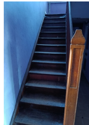
Accès au R + 1
