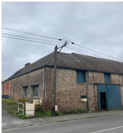
Façade de l'existant sur rue
