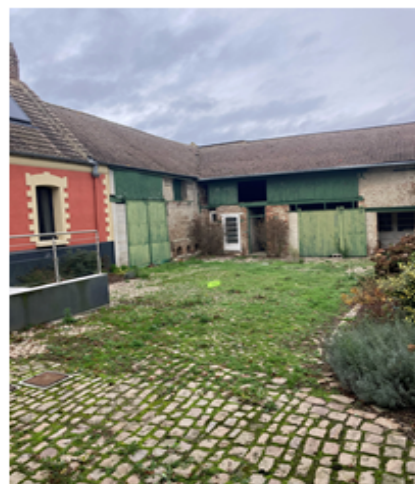
Cour intérieure commune aux locataires
